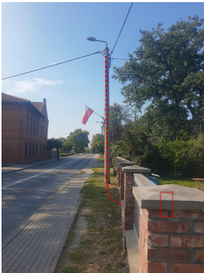
Trasa przyłącza kablowego od słupa nr 205 do szafki pomiarowej P1-Rs/LZV/F nr Z3318265 z lokalizacją przy ogrodzeniu od strony obiektu
