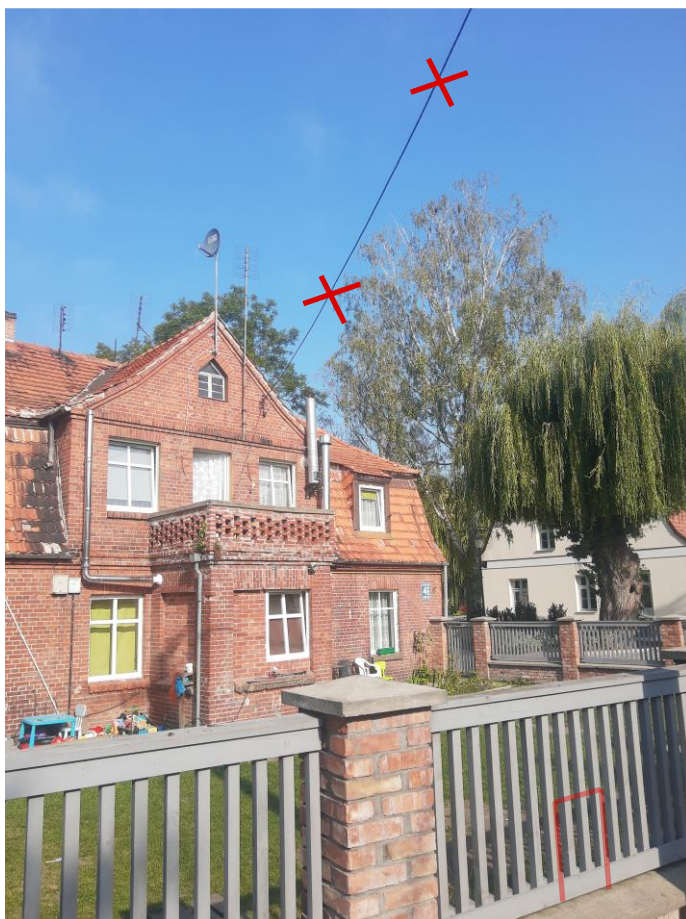
Zdjęcie przyłącza napowietrznego AsXSn 4x16\ od słupa nr 205 do budynku. Lokalizacja szafki pomiarowej Z3318265 przy ogrodzeniu od strony obiektu.
